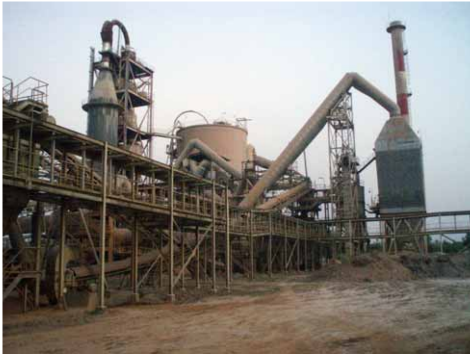
製造設備：右より排気処理電気集塵機、原料サイロ、原料ミル、プレヒータ及び調湿塔
