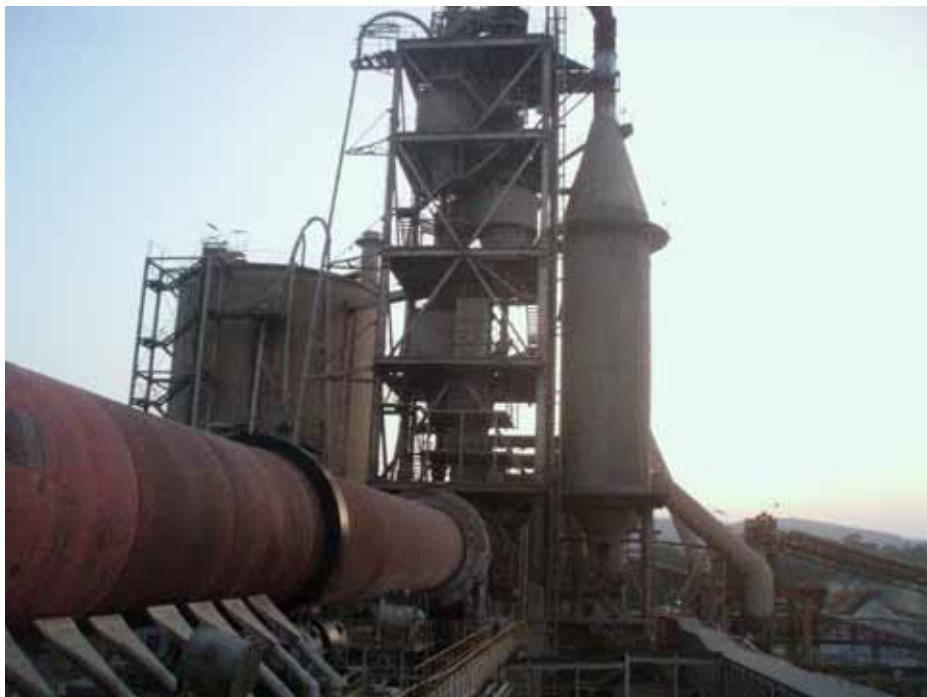
キルン出口側より：左より原料サイロ、プレヒータ、調湿塔
