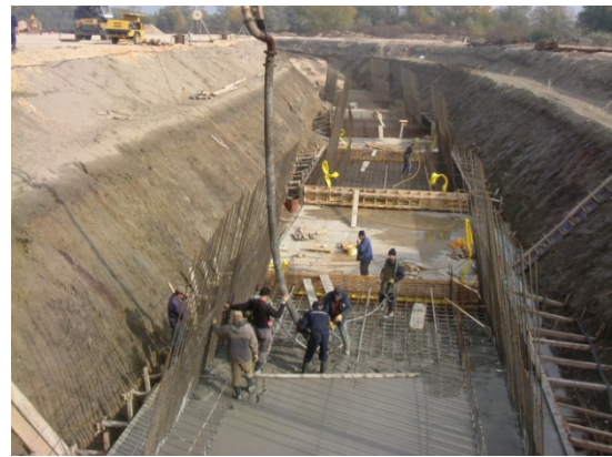
写真6 スラブのコンクリート打設
