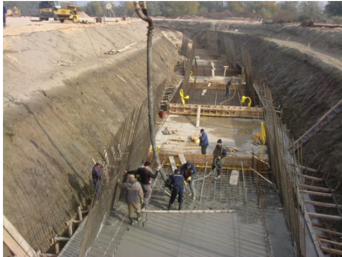
Photo3-3. Concreting
